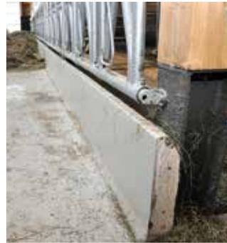
**AUCH DIE BARRENTEILE** sind als Fertigteile eingebaut. Der Futtertisch ist mit einer 1,30 m breiten Epoxid-Harz-Beschichtung versehen.
