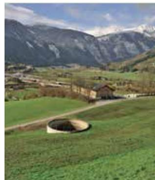
**EINE SPEZIELLE LÖSUNG** wurde für die Güllegrube gefunden. Die Betonarbeiten für einen Grubenraum direkt beim Stall hätten sich als kostenintensiv und aufwändig dargestellt. So entstand die Idee, die Grube etwa 60 Meter entfernt mit 33 Metern Höhenunterschied zu bauen. Einmal pro Monat wird die Gülle vom 200 m<sup>3</sup> großen Güllekeller (Zubau ist komplett unterkellert) in die 600 m<sup>3</sup> große Grube abgelassen.
