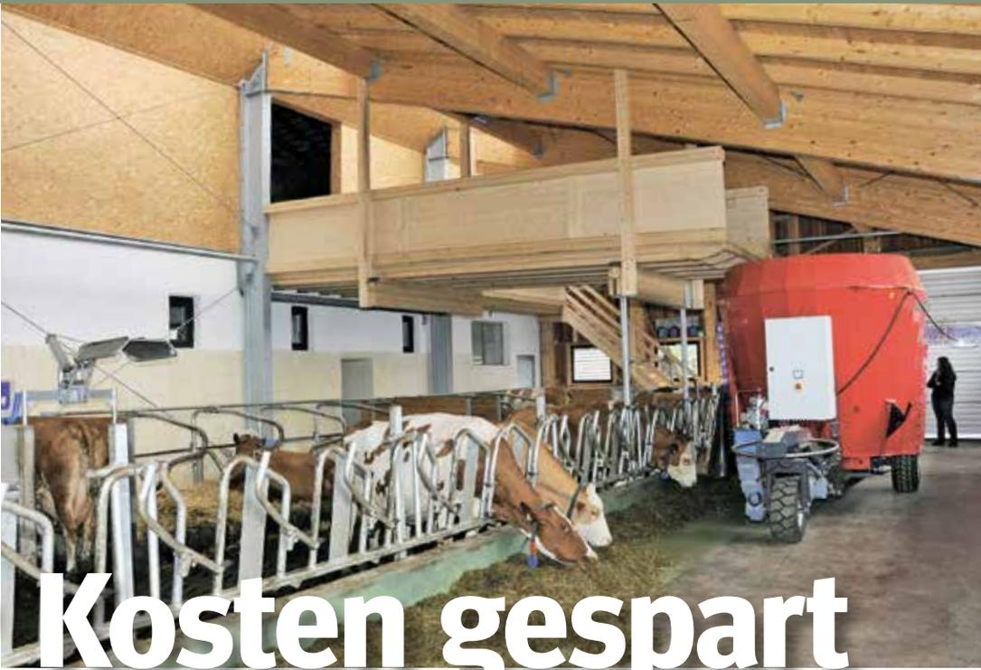
**DIE FUTTERBRÜCKE** verbindet das Futterlager aus dem alten Stall mit dem neuen Gebäude. Silage und Heu werden bequem in den elektrischen Mischwagen geschoben. Während man bei der Halle auf eine Systemlösung der Firma Wolf zurückgriff, wurde bei der Inneneinrichtung viel selbst gemacht.
