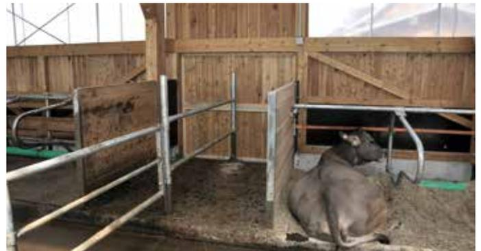
**AUSLAUF:** Zur tiergerechten Haltung gehört der ganzjährige Auslauf. Jede Altersgruppe hat ihren eigenen Bereich. Die Betonarbeiten sind im Süd- als auch Nordseitigen Auslauf soweit vorbereitet, dass jederzeit ein Breitschieber zur Auslaufreinigung montiert werden kann.
