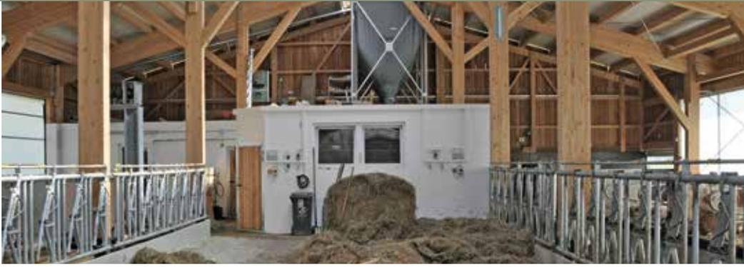
**DER KALTSTALL** hat im linken Jungviehbereich Hebefenster, bestehend aus Lichtplatten eingefasst mit Alu-Profil in Kunststoffführung, und im rechten Milchviehbereich Curtains. Der 5er-Side-by-side-Melkstand wurde aus Platzgründen gewählt.
